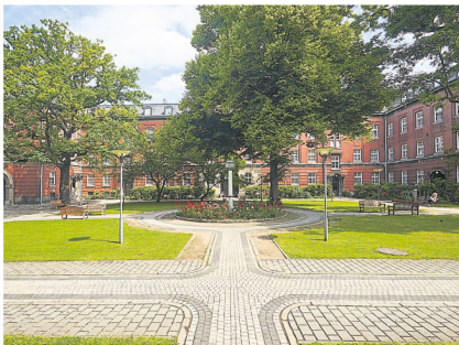
Das denkmalgeschützte Gebäude für die SUN-Wohn-Pflege-Gemeinschaft.
